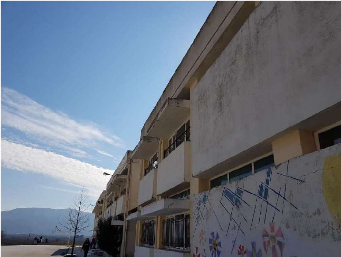
Σαθρά επιχρίσματα όψης που χρήζουν αποκατάσταση
