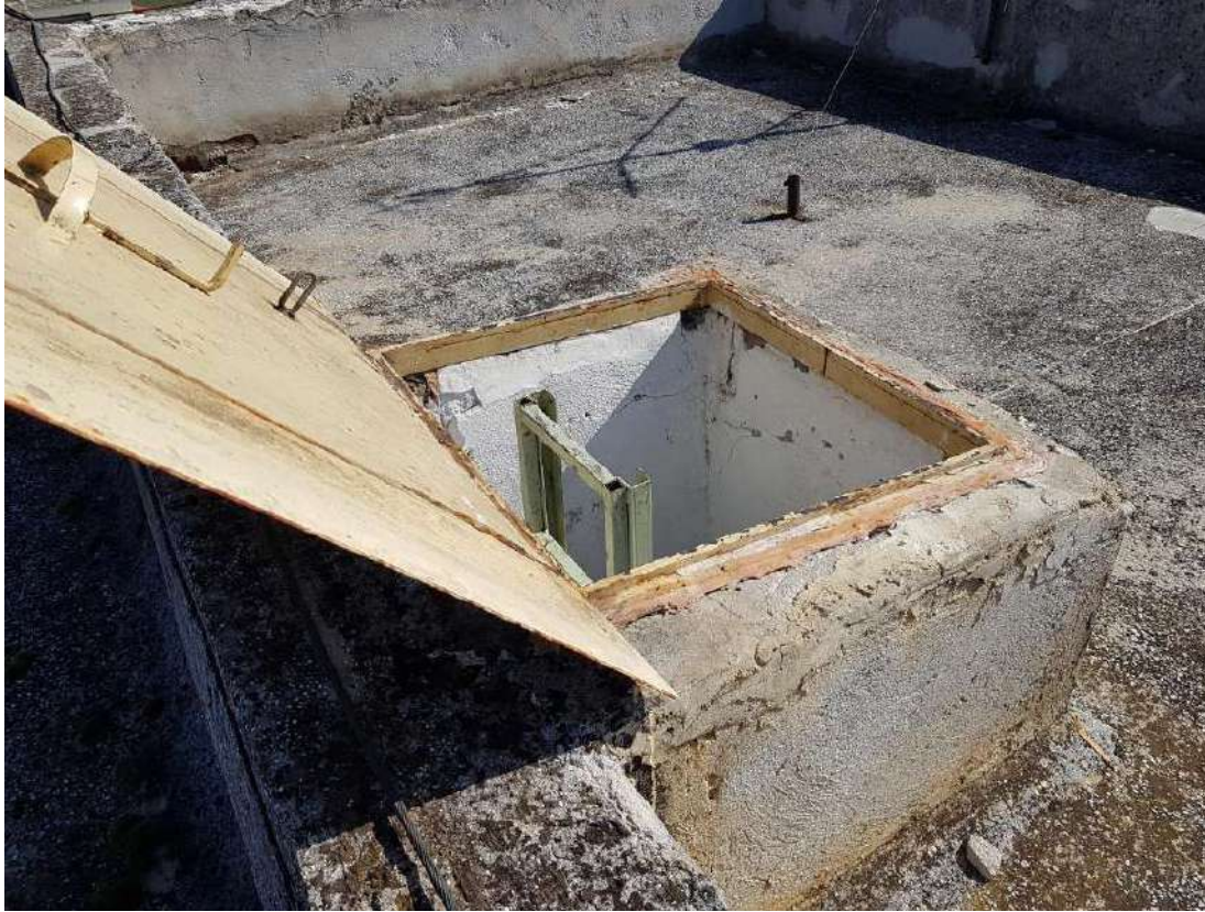
Καταπακτή στην πλάκα του ορόφου
