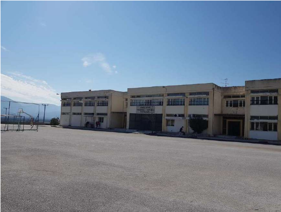
Ανατολική Όψη κτιρίου (συνέχεια της επάνω φωτογραφίας)
